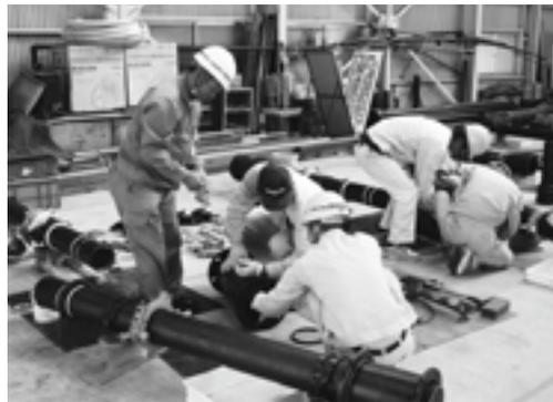
NS形ダクタイル鉄管の施工研修
