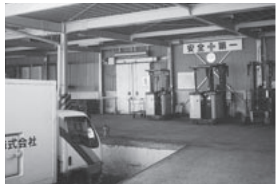
大型冷凍設備
