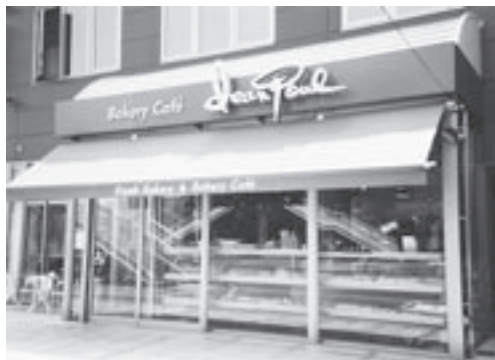
オーニングテントの施工例
