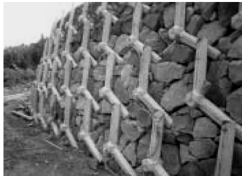
擁壁にブランチブロックを用いた施工例
